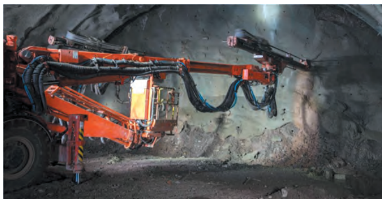
Rys. 7. Wiercenie otworów strzałowych [3]
