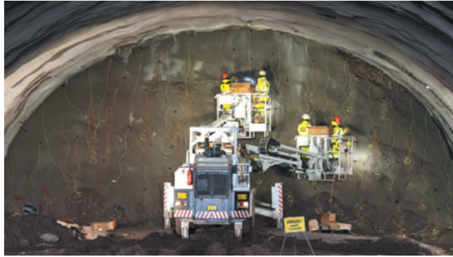
Rys. 8. Zakładanie materiałów wybuchowych [3]
