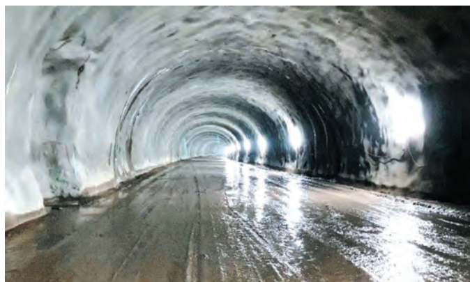
Rys. 12. Tunel po zakończeniu drążenia, wykonaniu warstwy wyrównawczej z torkretu oraz drogi technologicznej [3]
