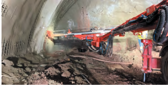
Rys. 9. Wykonanie obudowy wstępnej (tu: montaż kotwi skalnych) [3]
