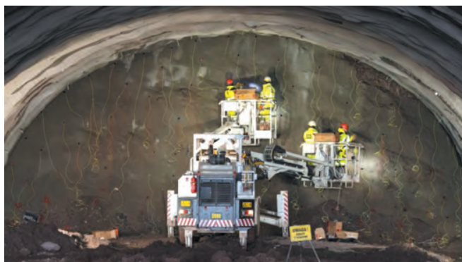
Rys. 8. Zakładanie materiałów wybuchowych [3]
