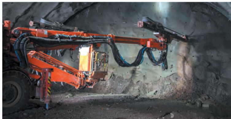
Rys. 7. Wiercenie otworów strzałowych [3]
