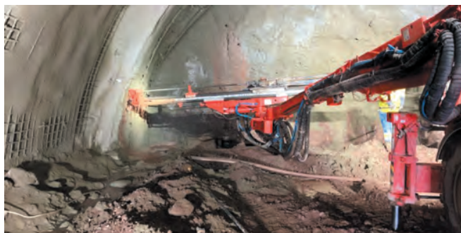
Rys. 9. Wykonanie obudowy wstępnej (tu: montaż kotwi skalnych) [3]
